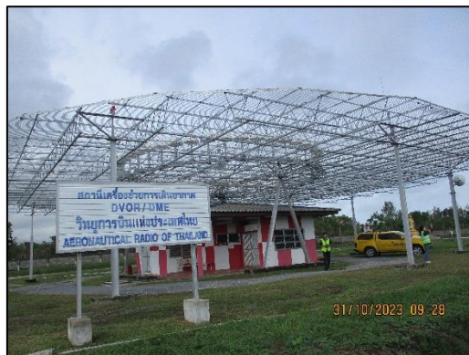
ภาพถ่ายที่ 1.4.2.4-3 สถานีเครื่องช่วยการเดินอากาศ DVOR/DME
